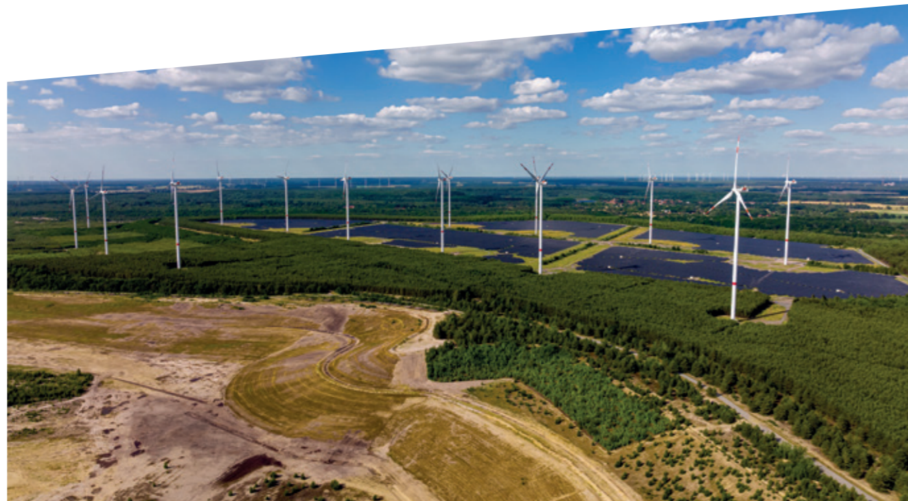
Der enercity Windpark Klettitz in der Lausitz wurde im ehemaligen Lausitzer Braunkohlerevier errichtet.
